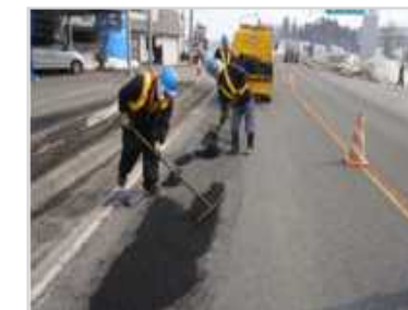
舗装版舗設作業
