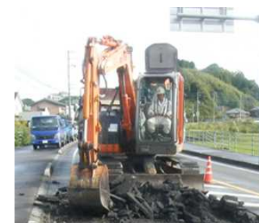
舗装版破碎作業
